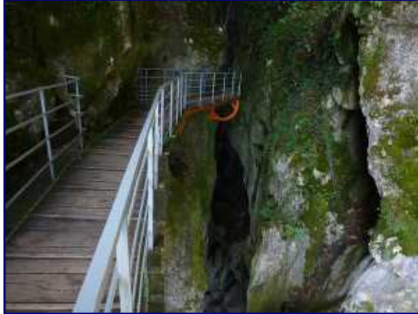
La passerelle des Gorges du Fier. Phase d'approche.
