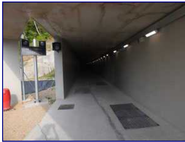
Entrée de tunnel cycliste et de secours sous la montagne du Chat.
