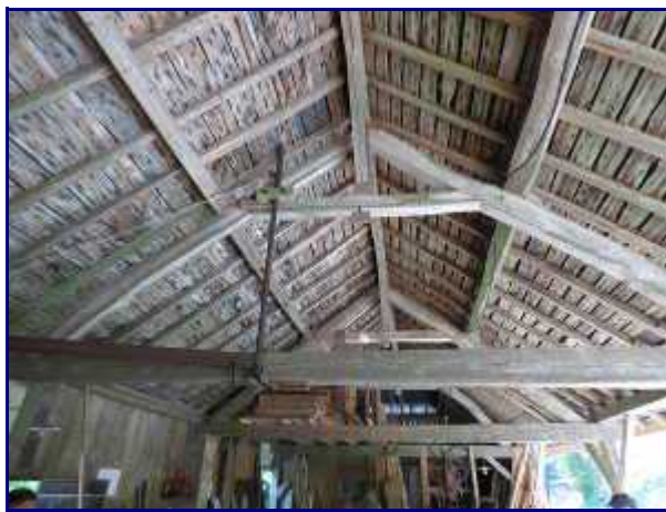
Détail de la charpente de la scierie.
