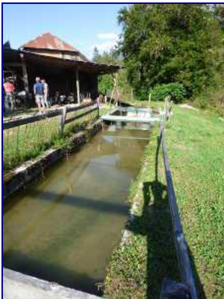
Le bief d'arrivée d'eau.
