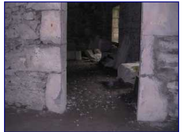
Les travaux d'entretien et de reconstruction ne s'arrêtent jamais à Miolans.
