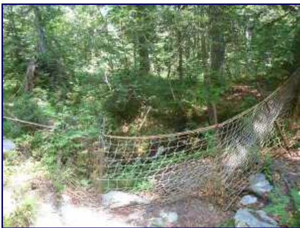
De nombreux filets de protection sont installés autour des cavités les plus faciles d'accès à Margérial.
