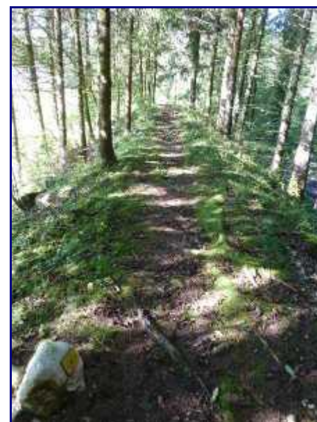
La première digue construite après l'éboulement de 1931, coté ouest pour protéger les maisons.
