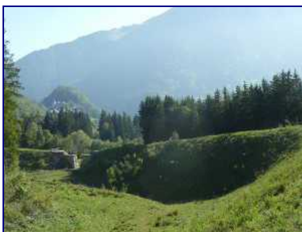
La digue du 2eme casier de dépôt. L'église et le verrou glaciaire du Châtelard en arrière plan.
