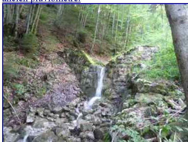
1 des 8 seuils sur le torrent qui descend des Garins dans les gorges des Manauds, pour limiter le ravinement.
