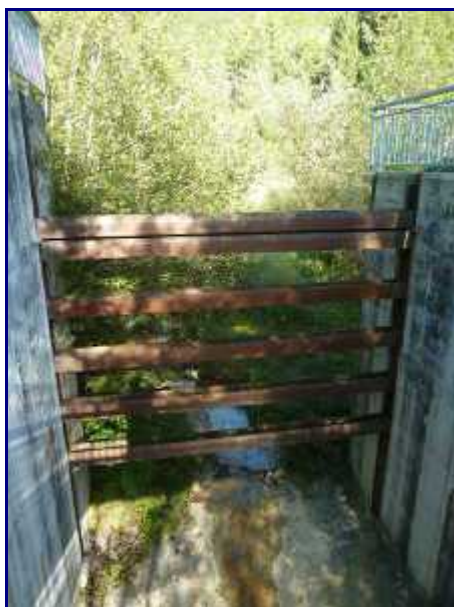
Le goulot de passage de la 3ème digue avec les poutrelles pour retenir les arbres.
