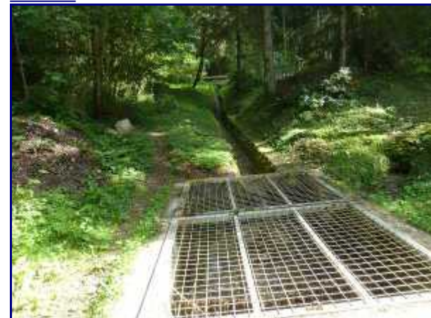
Un canal puis un bac de décantation sous la grille.
