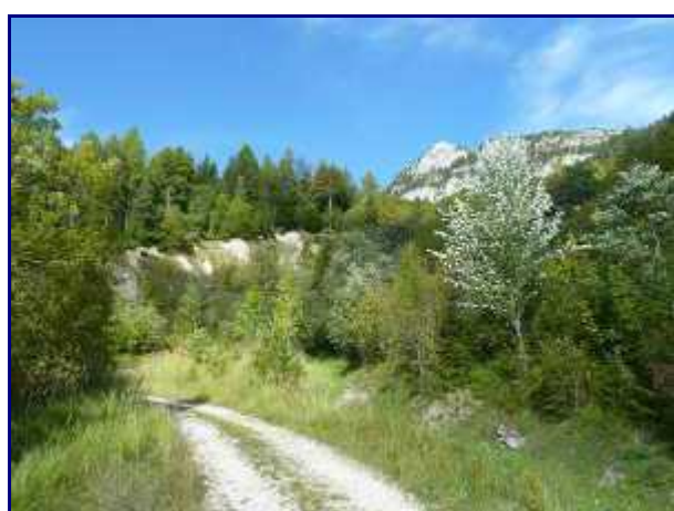
En face, décrochement de terrain dû à un ancien glissement. A droite, crête du Julioz.
