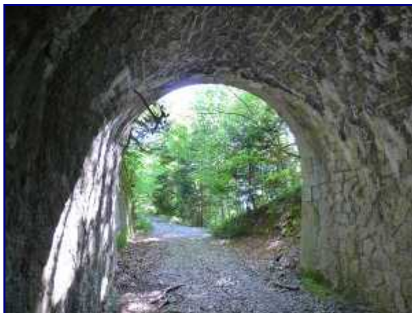
Sortie du tunnel de pré Farnier. En haut, un ancien support électrique.
