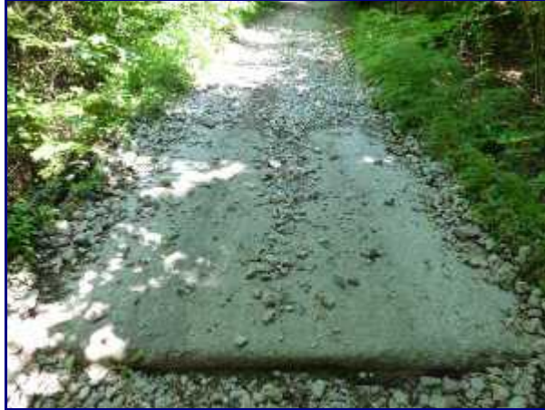
Le dallage d'un passage inférieur.
