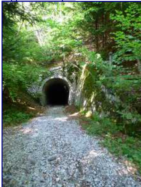
Vue arrière. Sortie du tunnel de pré Farnier.
