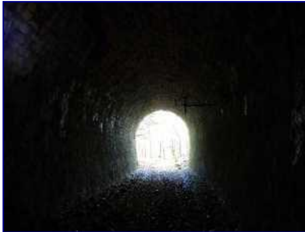
Dans le rétro, intérieur du tunnel de pré Farnier.
