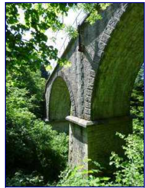
Le viaduc des Fontanelles. Une des cinq piles du pont.
