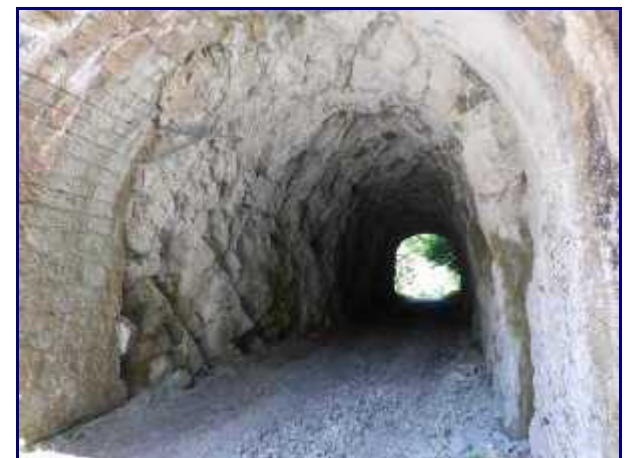
Intérieur du premier tunnel, en aval de Pré Japert.
