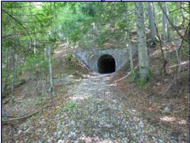
Arrivée au tunnel de pré Farnier.
