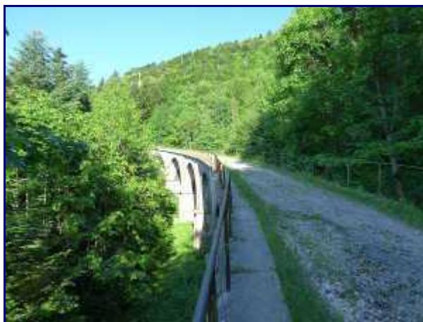
Le viaduc des Fontanelles, sur l'ancien tracé de la crémaillère.
