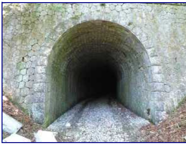
Entrée du tunnel de pré Farnier.
